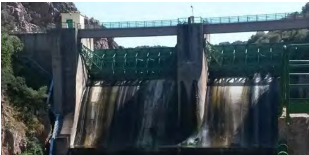
Fig. 41. Sbarramento sulla diga di Casteldoria sul Fiume Coghinas.
