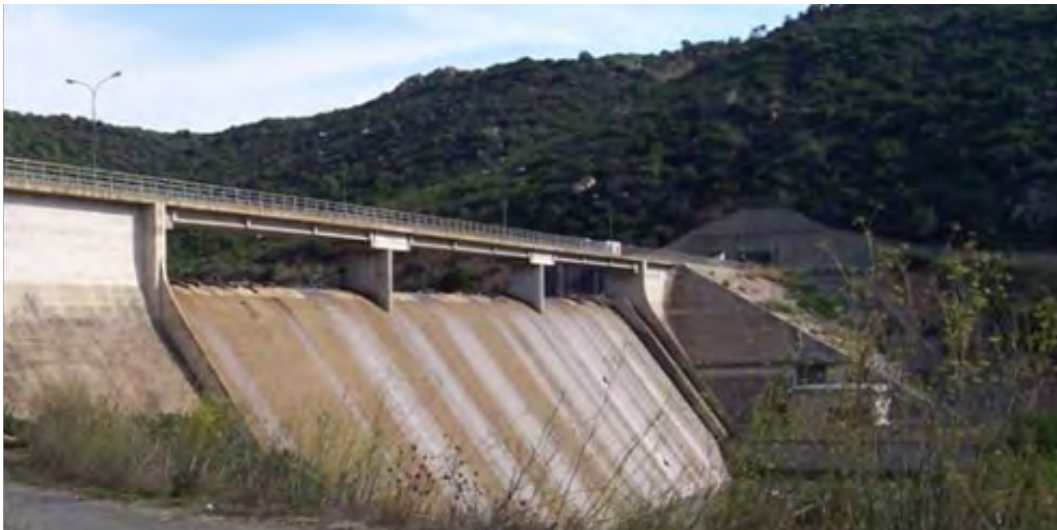
Fig. 40. Sbarramento sulla diga del Riu Girasole (Ogliastra).
