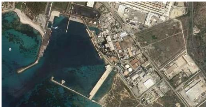
Vista aerea del porto di Portovesme
