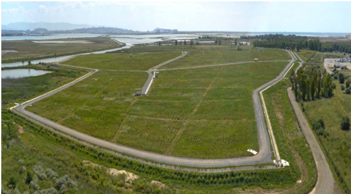
Figura 6.2-4: Panoramica post intervento
