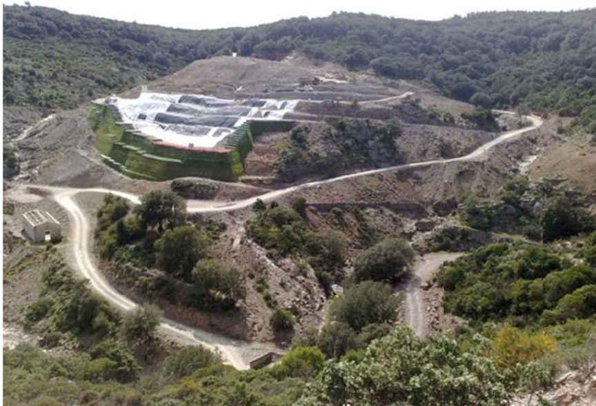
Figura 6.3-5: Sito di raccolta durante l'impermeabilizzazione del fondo
