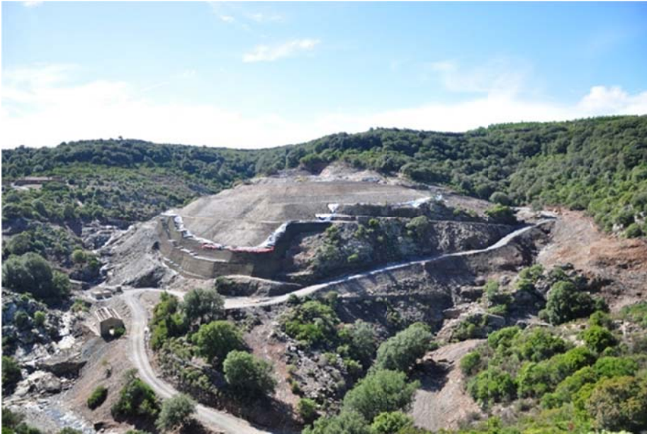
Figura 6.3-6: Sito di raccolta in fase di ultimazione
