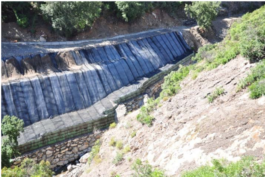
Figura 6.3-7: Particolare della MISP di una discarica mineraria a bordo alveo – fase di realizzazione
