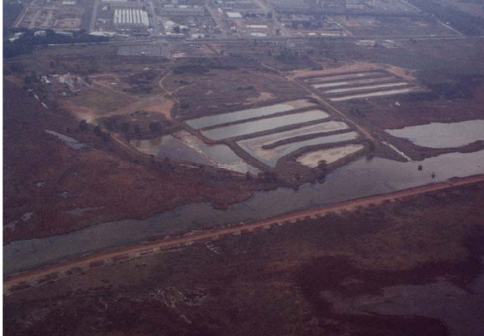
Figura 6.2-2: Fasi realizzazione intervento
