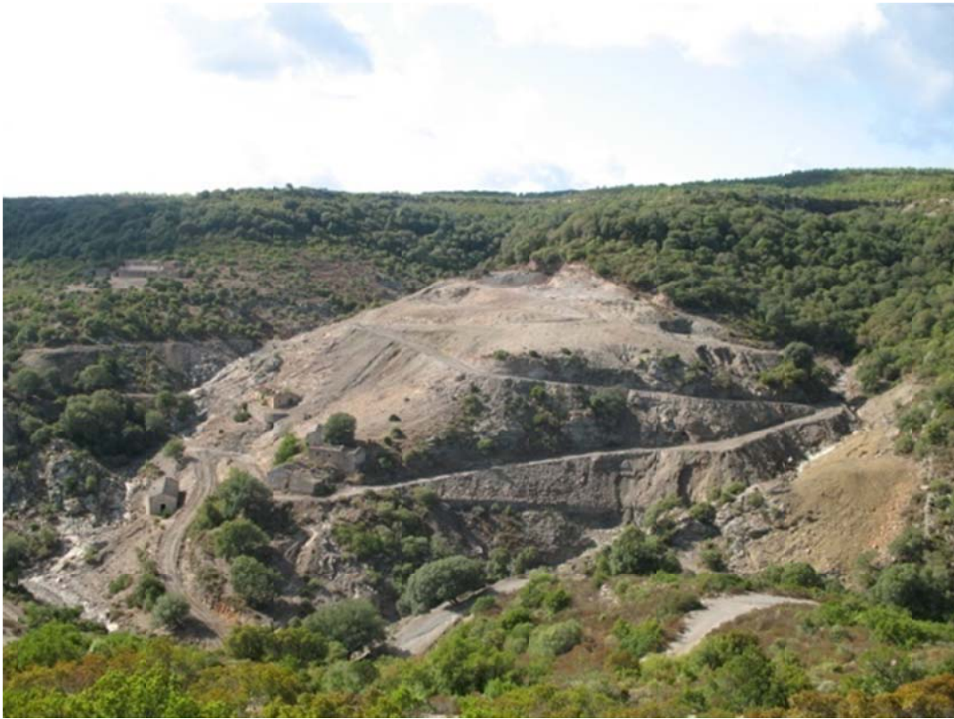
Figura 6.3-3: Discarica mineraria sede del Sito di raccolta – pre intervento
