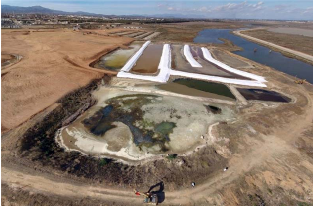
Figura 6.2-3: Fasi realizzazione intervento
